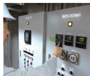
空調計装設備の点検
