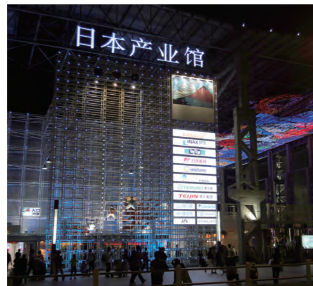
看板用LED照明
