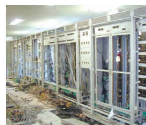
制御盤リプレイス工事
