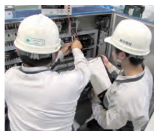
プラント計装設備の点検
